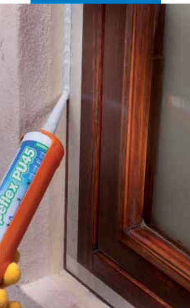
Sigillatura elastica giunti di costruzione
