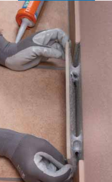
Incollaggio elastico di elementi costruttivi
